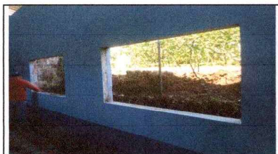
FOTO 9: PINTURA EN MUROS EXTERIORES E INTERIORES
