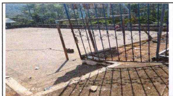
FOTO 11: Mantenimiento a portones de metal de rejas
