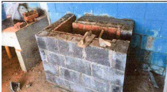
FOTO 7: Sustrucción de estufa rural (completa) incluye chimenea y plancha de metal
