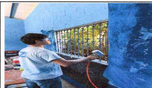
FOTO 5: Mantenimiento a balcones de metal
