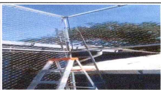
FOTO 12: Reparación de tubo hg y malla galvanizada
