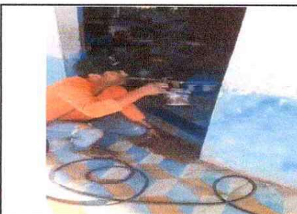
FOTO 3: Mantenimiento a estructura (lijado, cambio de tubo, cepillado, sujeciones, aplicación de pintura)
